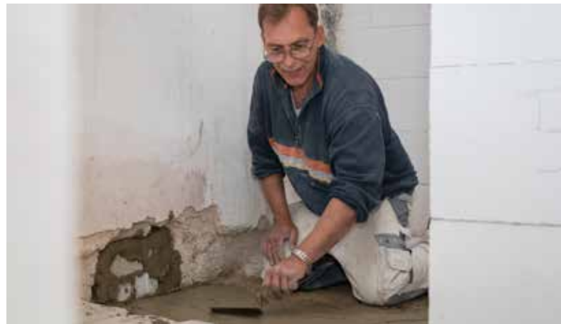
Gut voran gehen die Sanierungsarbeiten am Tusem-Clubhaus im Fibelweg. Andreas Schmitt und Christoph Nengelken erläutern Christian Kukuk vom Tusem den Stand der Dinge. Bild unten: Den neuen Boden trägt u.a. Bauarbeiter Dirk Schimpfke auf.
