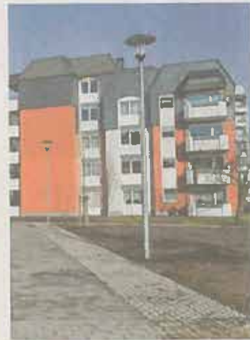
Neue Lampen, neue Wege, frischer Anstrich: Die Siedlung wird verschönert.
