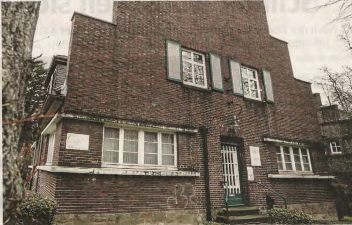
Die Polizeistation auf der Margarethenhöhe ist seit langem in einem markanten Gebäude an der Sommerburgstraße untergebracht. Im kommenden Jahr sollen die beiden Bezirksbeamten nach Bredeney umziehen. FOTOS: ANDRÉ HIRTZ / FFS
