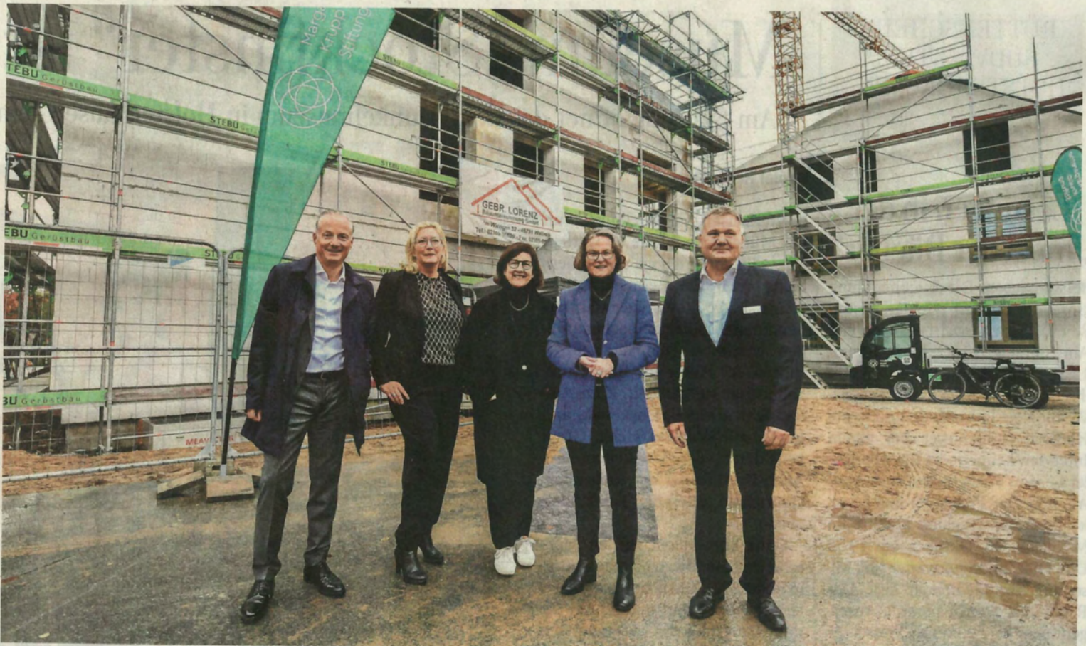
Der Rohbau des Verwaltungsgebäudes der Margarethe-Krupp-Stiftung in Essen steht: Das feierten (v.l.) Alexander Rychter (Verband der Wohnungs- und Immobilienwirtschaft Rheinland Westfalen), Julia Jacob (Bürgermeisterin), Petra Wörner (Architektin WTR), Ina Scharrenbach (NRW-Bauministerin) und Michael Flachmann (Margarethe-Krupp-Stiftung).
