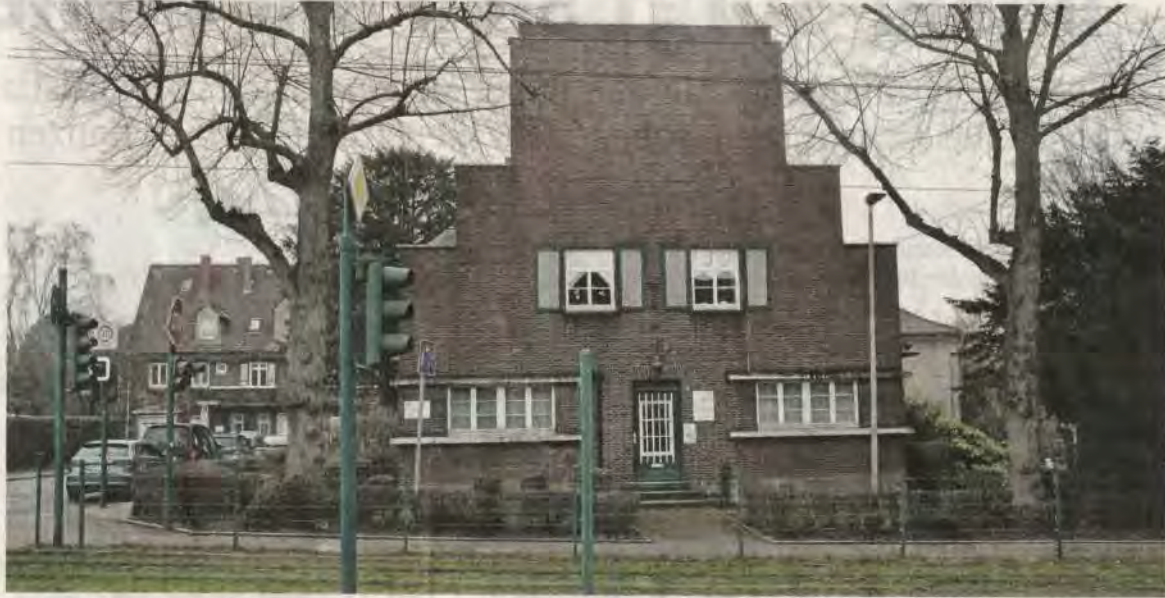
Die Polizeiwache an der Sommerburgstraße soll im August aufgegeben werden. Die Beamten bleiben weiter für die Margarethenhöhe zuständig, werden aber in Bredeney angesiedelt sein.
