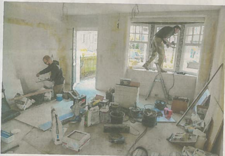
Derzeit laufen die Renovierungsarbeiten in den Räumen des ehemaligen Kloiddtadens am Laubenweg 11.
