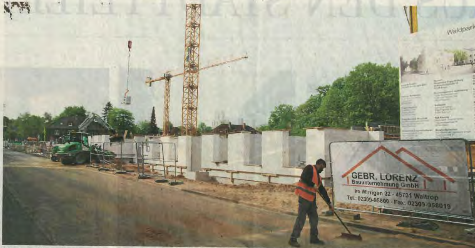
Die neuen Wohnhäuser am Lehngrund auf der Margarethenhöhe nehmen Form an. Einzug soll im Herbst 2023 ein.
