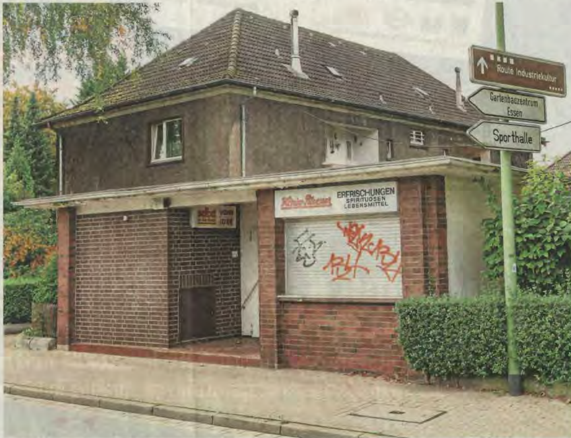
Verschlossen und beschmiert: Das kleine Gebäude an der Sommerburgstraße, das früher den Kiosk beherbergte, soll deutlich attraktiver werden.
